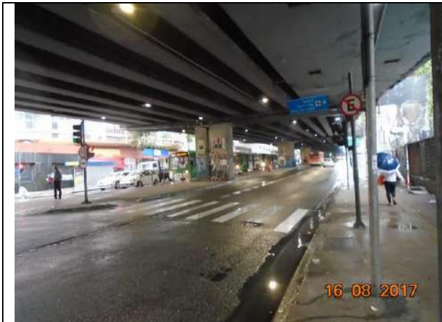
Foto 42: Trecho do traçado no cruzamento com o Elevado Presidente Artur da Costa e Silva.
