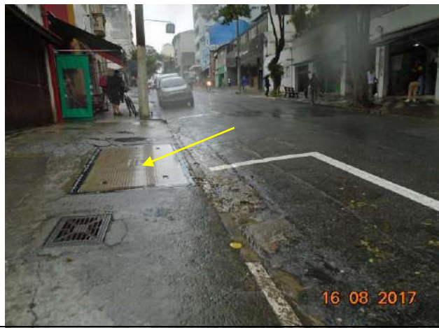
Foto 07: Poço de Visita (indicado pela seta amarela) da Eletropaulo ainda na Rua Fernando de Albuquerque.
