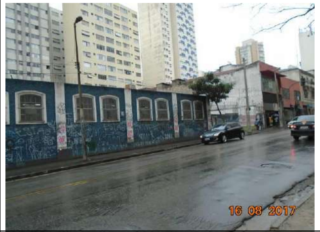
Foto 02: Lateral da edificação da ETD Augusta, na Rua Augusta.
