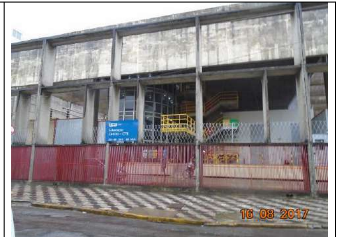
Foto 43: Subestação Centro – CTR.
